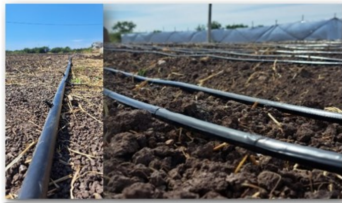
Figura 13. Instalación de sistema de riego por goteo. Fuente: Elaboración propia
